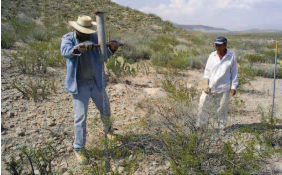
Colocación de los postes metálicos para el cerco.
