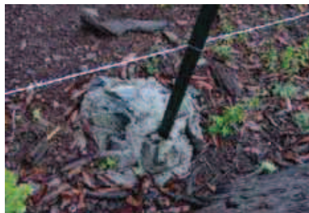
Cimiento para sujetar el poste metálico.
