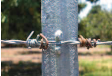
Detalle del alambre recosido.
