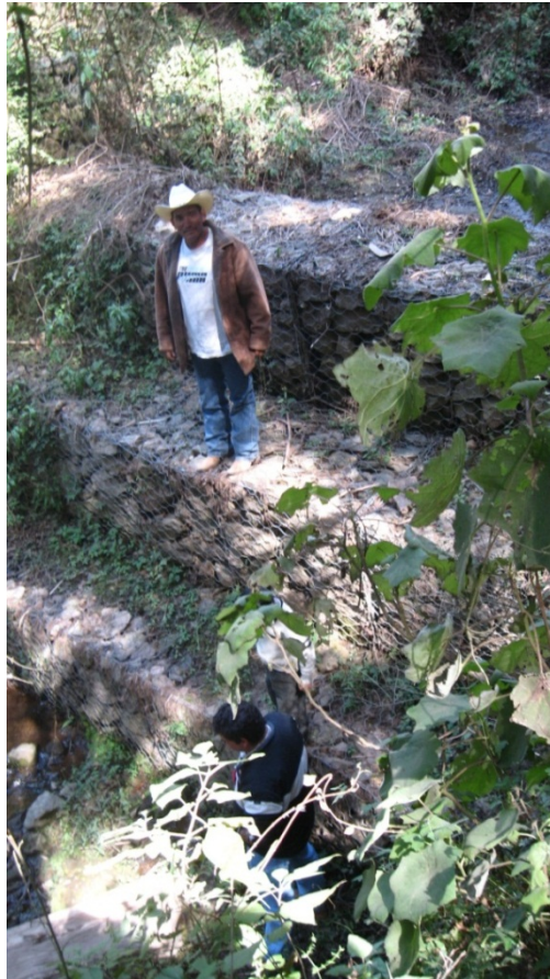
Ilustración 3. Práctica de control de la erosión en barrancas (Ejido El Potrero)
